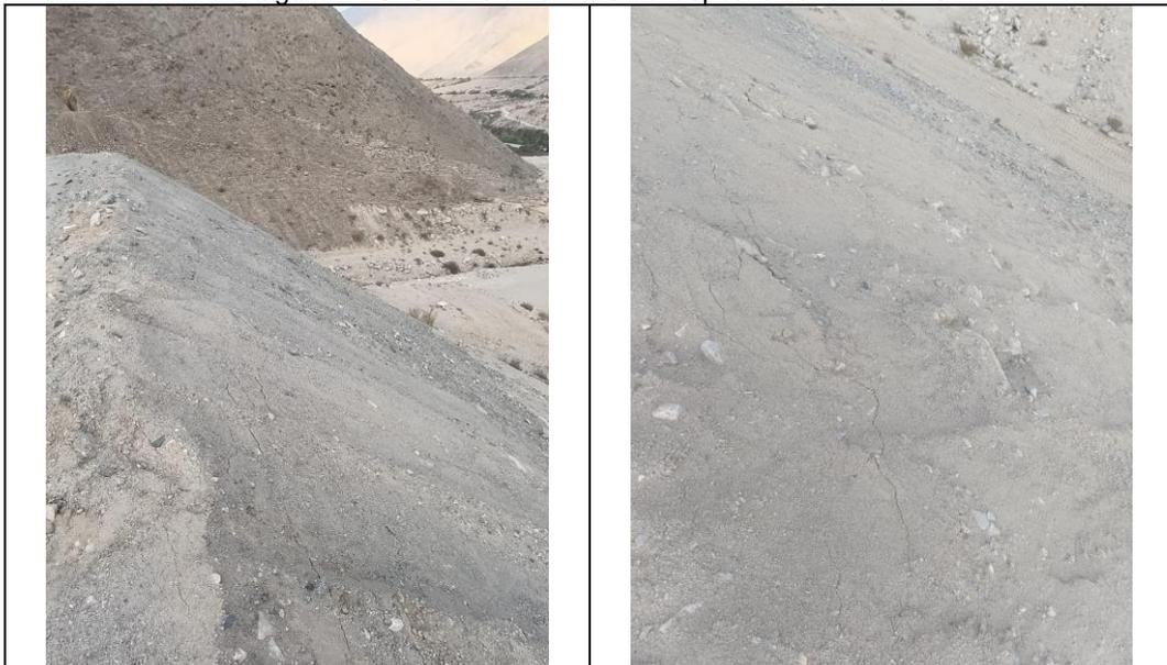
Presencia de grietas en el talud del depósito de relave N° 3
